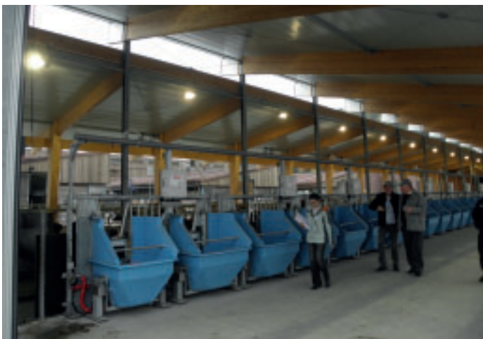
Die Einzelfutterkrippen mit Gewichtserfassung; oben sieht man den Abstand zwischen den beiden Dachneigungen mit dem Ziel einer besseren Belüftung
