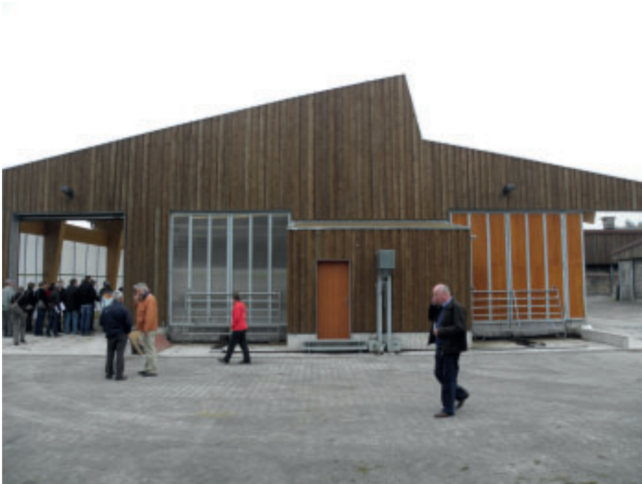
Das Dach des neuen Stalles verfügt über asymmetrische Neigungen um im Sommer wie im Winter eine optimale Belüftung des Gebäudes zu gewährleisten.
